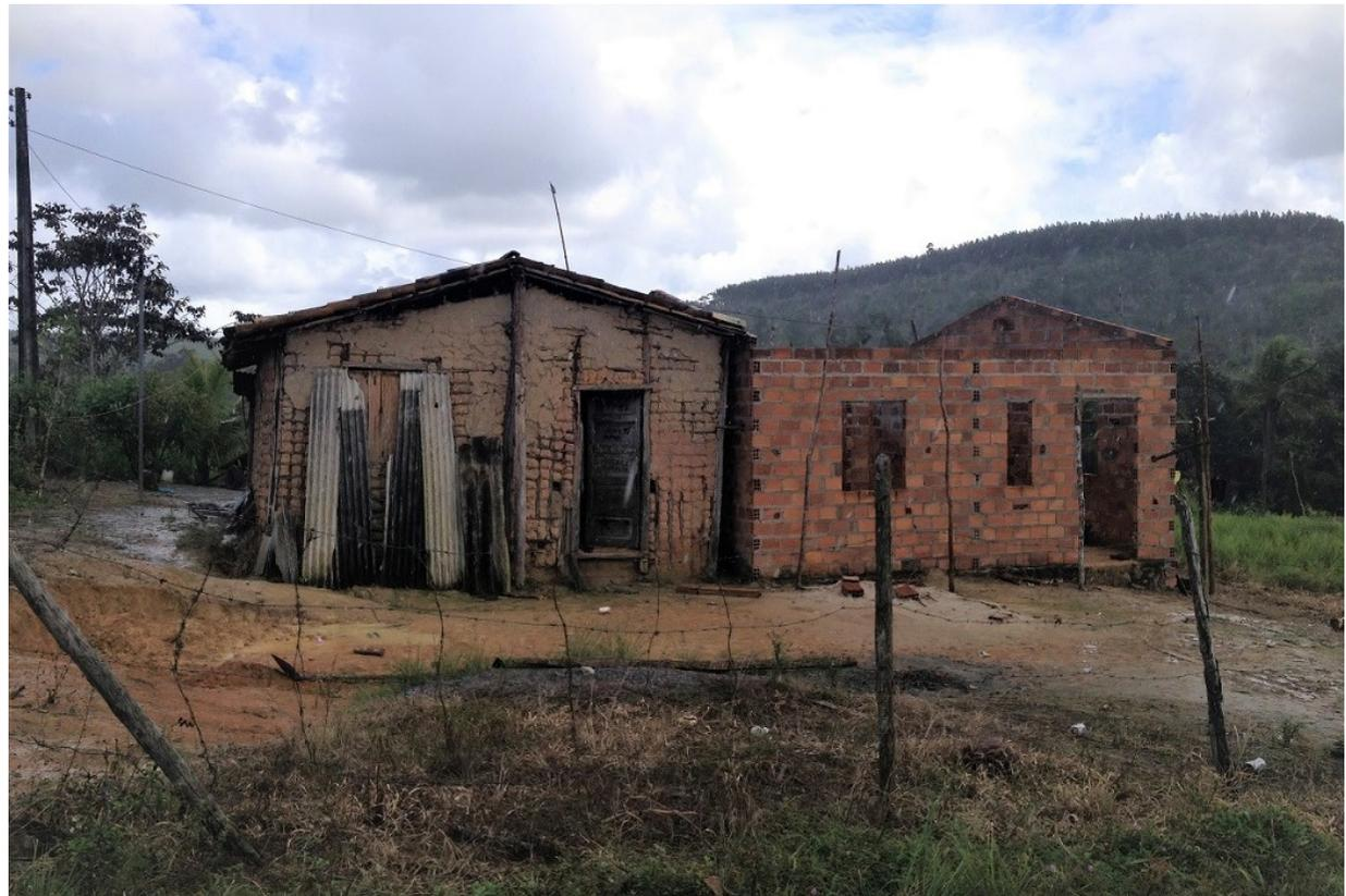
Figura 6 – Substituição da moradia de taipa de mão por edificação com alvenaria de bloco cerâmico na zona rural de Cardeal da Silva (BA), 2014 (Crédito: Carolina N. Vieira)
