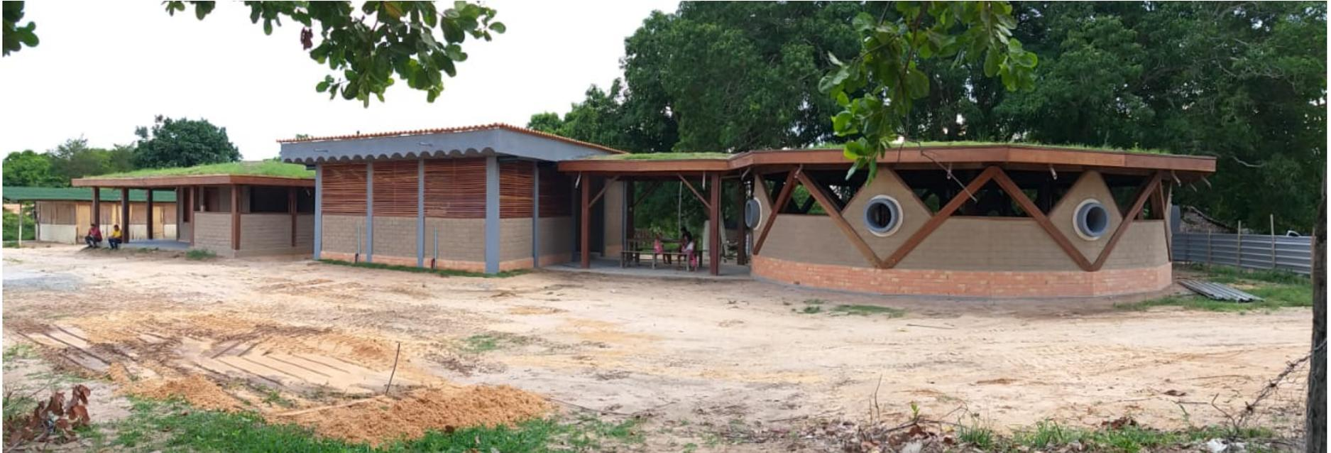
Figura 1 - Da direita para esquerda: Redário, cozinha tradicional e habitação modelo construídos com adobe na terra indígena Caru (MA), 2019. Projeto e construção: Tibá Arquitetos (Crédito: Michel Habib Ghattas)
