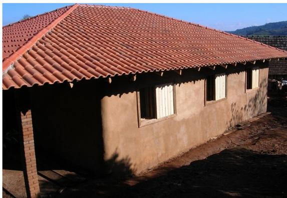
Figura 7 - Casa em Paial (SC), parede externa de terra ensacada, internas de BTC, contrapiso de solo-cimentado compactado, revestimento de argamassa de terra. Autoconstrução direcionada por atividades de capacitação, 2009. Projeto: Yuri Moraes (Crédito: Cecília Prompt)
