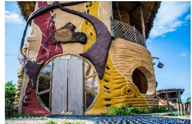
Figura 4 - Eco Hostel em Barra Grande (PI), com paredes de terra ensacada e taipa de mão. Projeto: César Augusto da Costa (Crédito: Raízes Eco Hostel Barra Grande)
