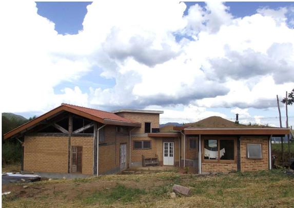
Figura 2 - Residência com estrutura de madeira e vedação com adobe, em Piracaia (SP), construída em 2010 (Projeto e crédito: Bianca Joaquim)
