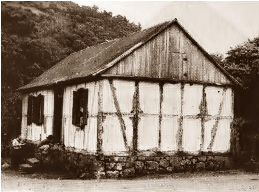
Figura 3 - Casa Vogt, em Sinimbu - RS, um dos únicos exemplares de arquitetura com estrutura em enxaimel vedada com taipa do sul do Brasil (Fonte: adaptado de Weimer, 1983, p. 142)
