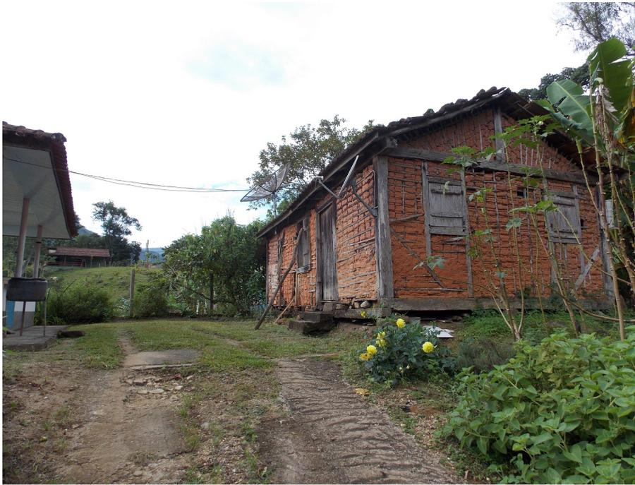
Figura 5 - Residência construída em enxaimel e vedada com taipa. Casa D. Nilta Verli Mafort, Lumiar, Nova Friburgo - RJ, demolida em 2019 (Fonte: Banco de Imagens Laboratório do Lugar e da Paisagem, EAU/UFF)
