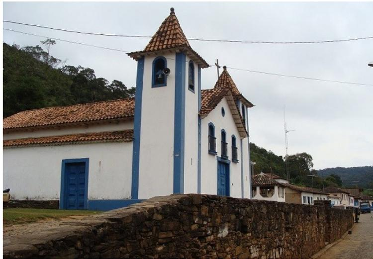
Figura 8 - Igreja Matriz de São Bartolomeu, construída com sistema estrutural de madeira e vedação de adobe e com alvenaria de pedra, Ouro Preto (MG), 2009 (Crédito: Alexandre Mascarenhas)
