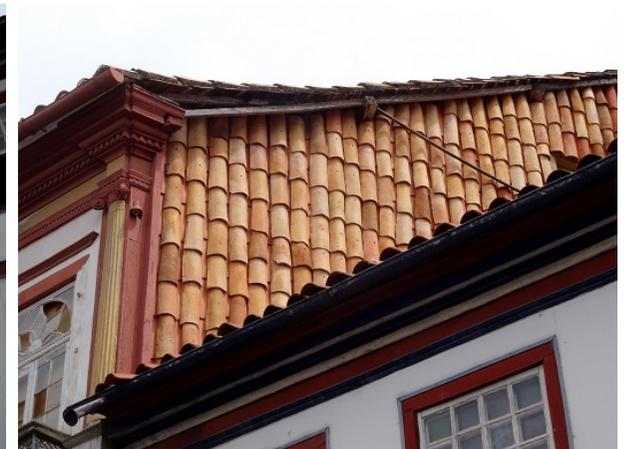
Figura 14 - Casarão de taipa de mão com terra e cascalho em Diamantina (MG). Detalhe construtivo de proteção da empena contra águas de chuva, encoberta com telhas coloniais cerâmicas, tradição da região norte de Portugal, 2017
