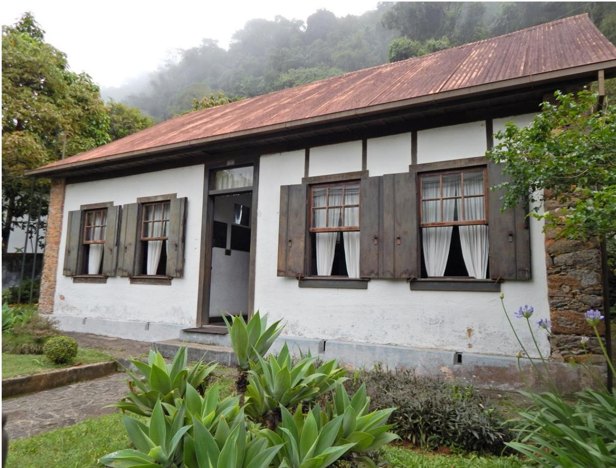
Figura 4 – Casa de Johan Gottlieb Kaiser (1847), situada na Castelânea, Petrópolis - RJ. Paredes laterais em alvenaria de pedra, paredes frontal e de fundos em enxaimel vedada com taipa assentadas sobre baldrame de pedra. Atualmente abriga o Museu Casa do Colono (Fonte: do autor)
