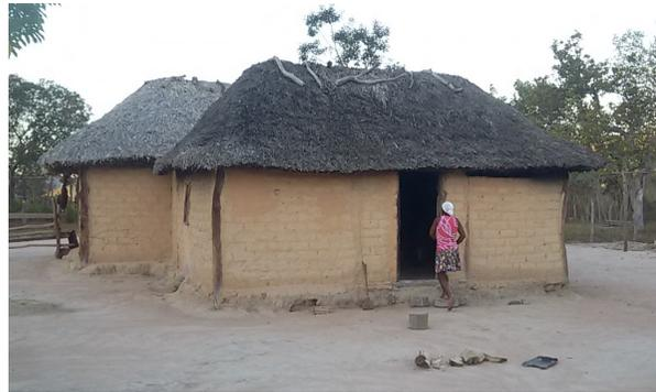
Figura 2 – Casa Kalunga típica, com adobe e estrutura de madeira, em Vão de Almas, Cavalcante (GO), construída na década de 1970 (Crédito: Sérgio Pamplona)
