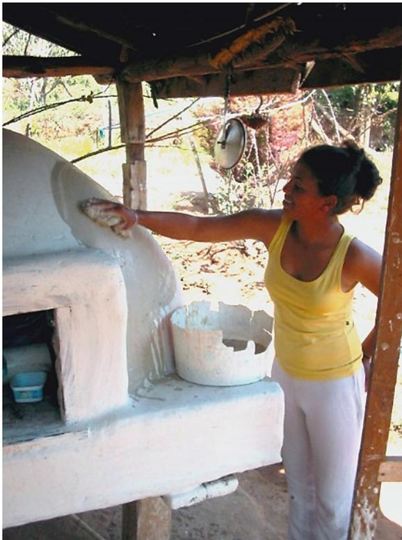
Figura 1 – Barreado: solo argiloso diluído em água aplicado sobre a superfície com auxílio de pano. Araponga (MG), 2005 (Crédito: Fernando de Paula Cardoso)
