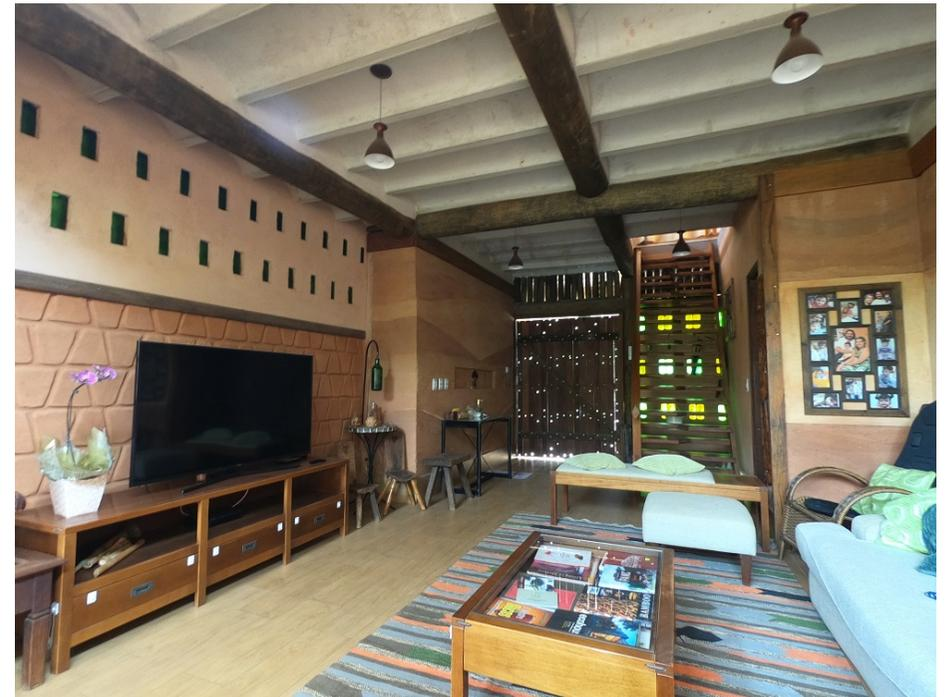
Figura 6 - Interior da residência construída com pau a pique, adobe e taipa de pilão em Atibaia (SP), 2015 (Projeto e crédito: Michel Habib Ghattas)
