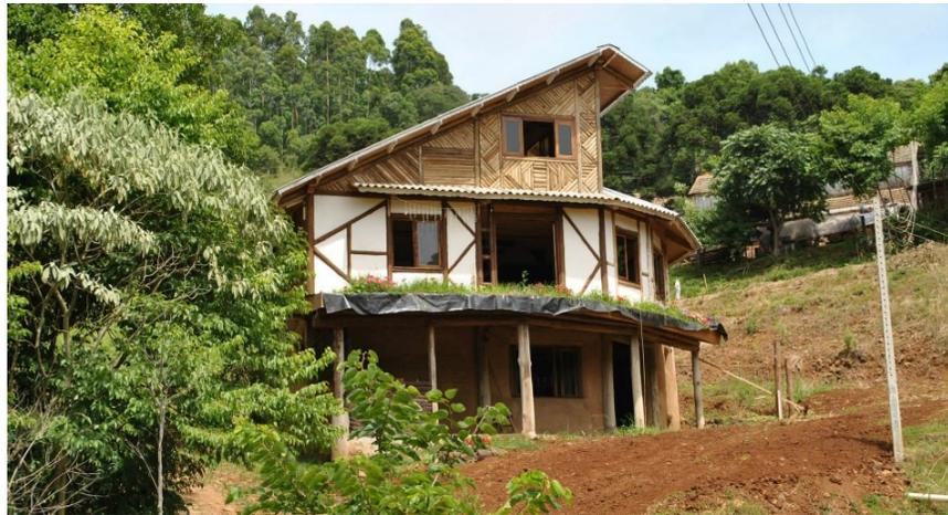
Figura 8 - Residência de terra ensacada e taipa de mão em Seara (SC). Autoconstrução, 2011 (Projeto e crédito: Cecília Prompt)
