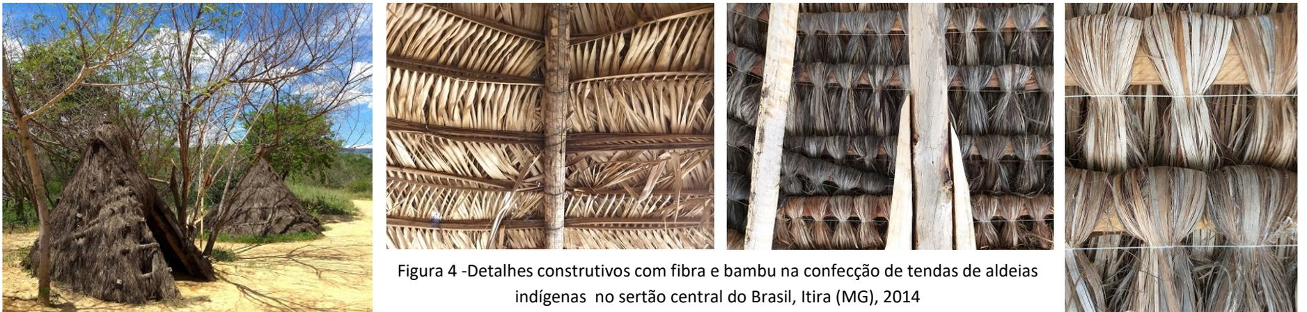
Figura 4 - Detalhes construtivos com fibra e bambu na confecção de tendas de aldeias indígenas no sertão central do Brasil, Itira (MG), 2014
