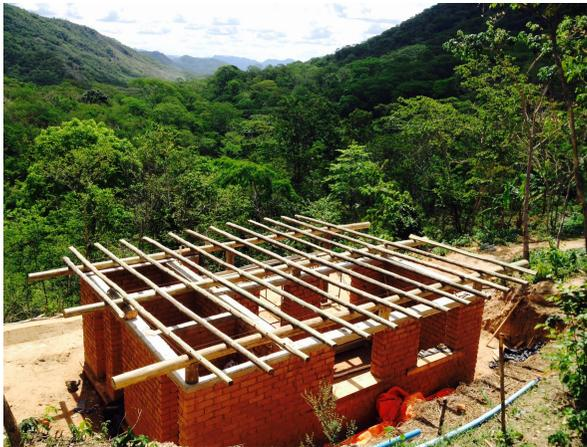
Figura 3 - Edificação executada durante a Oficina de Apoio à Permacultura, em Maranguape (CE), com paredes de adobe e cobertura em madeira para estrutura do teto verde, 2018 (Projeto e Crédito: Márcio Holanda)
