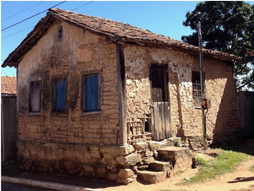
Figura 1 - Casa com fundação de pedra e parede com taipa de mão em Itatiaia, Ouro Branco (MG), 2001 (Crédito: Raymundo Rodrigues)
