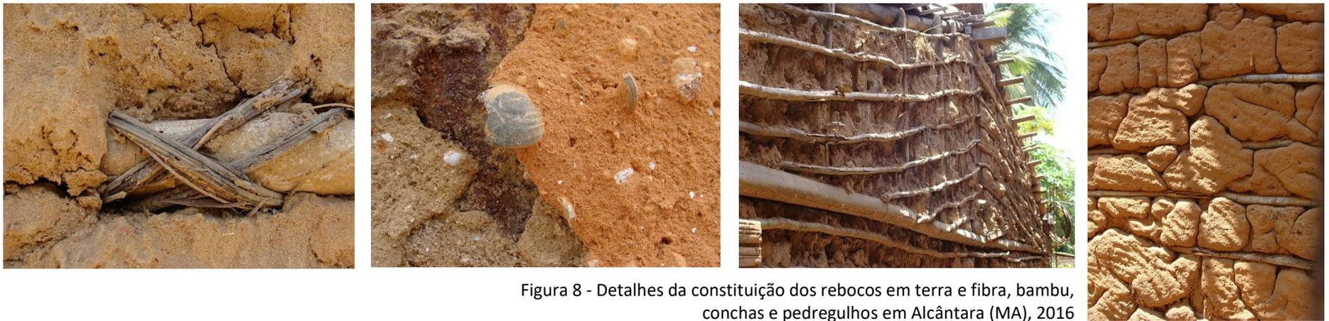
Figura 8 - Detalhes da constituição dos rebocos em terra e fibra, bambu, conchas e pedregulhos em Alcântara (MA), 2016
