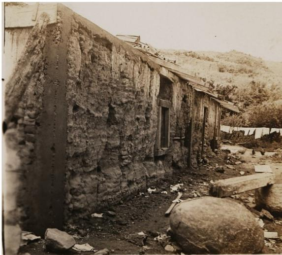
Figura 1 - Sítio Santo Antônio, São Roque (SP). Execução de pilares de concreto na taipa de pilão da Sede, 1940-1947 (Fonte Arquivo Central do IPHAN, Seção Rio de Janeiro, doc. n. F24125)
