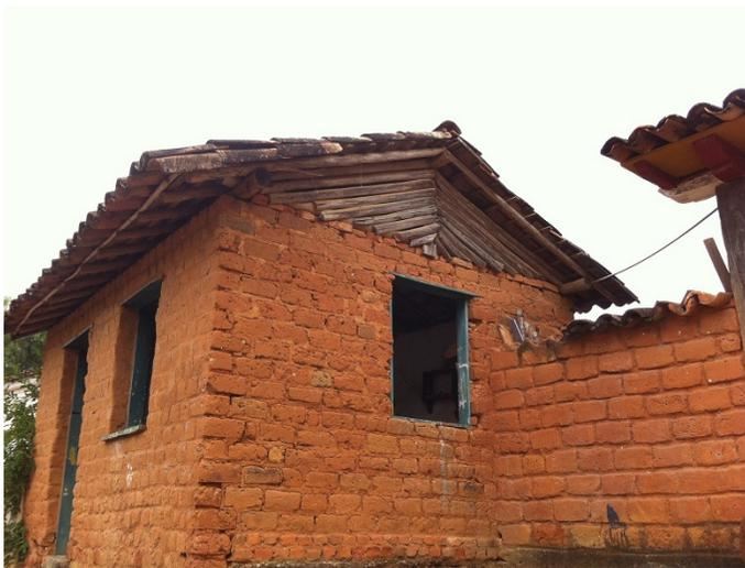
Figura 5 - Casa de adobe, alvenaria de meio tijolo, em Bichinho (MG), 2015
