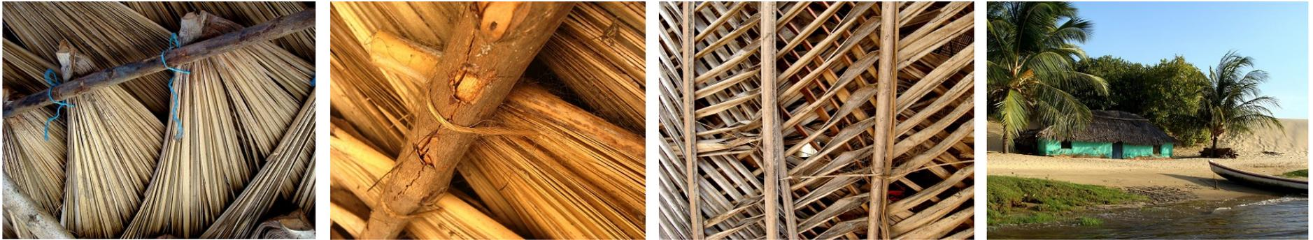
Figura 3 - Detalhes construtivos com fibra natural, bambu e vegetação nativa na confecção de coberturas e estruturas indígenas nos Lençóis Maranhenses (MA), 2012
