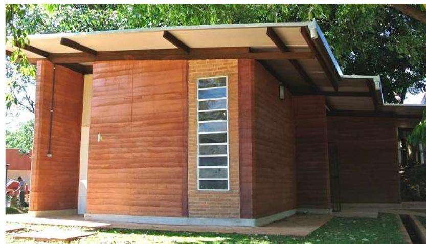
Figura 5 - Protótipo de bambu e terra executado no canteiro de construções experimentais na Universidade Federal de Santa Catarina, 2009 (Crédito: Lisiane Ilha Librelotto)
