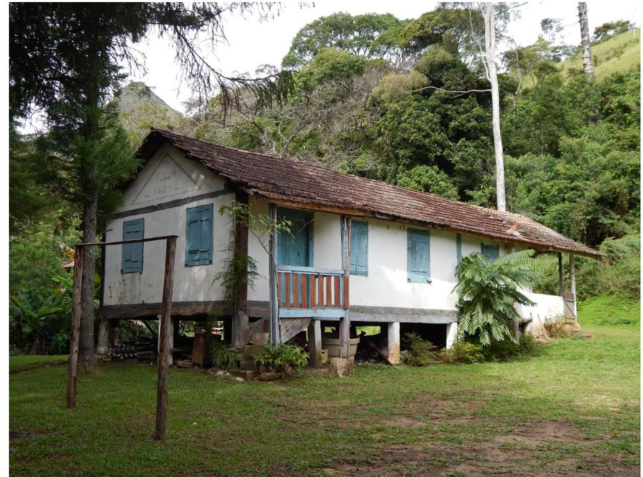
Figura 6 - Residência construída em enxaimel e vedada com taipa. Boa Esperança de Cima, Distrito de Lumiar, Nova Friburgo - RJ (Fonte: Banco de Imagens Laboratório do Lugar e da Paisagem, EAU/UFF)
